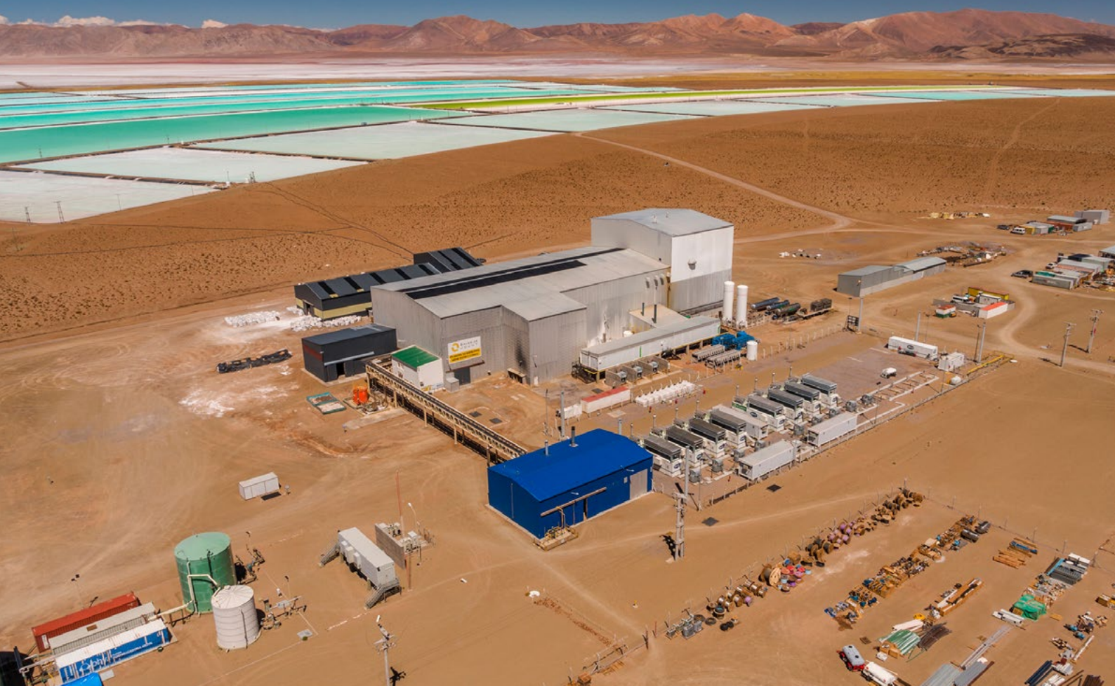
Vista aérea de piletas y planta de producción. Proyecto Olaroz, Provincia de Jujuy.
