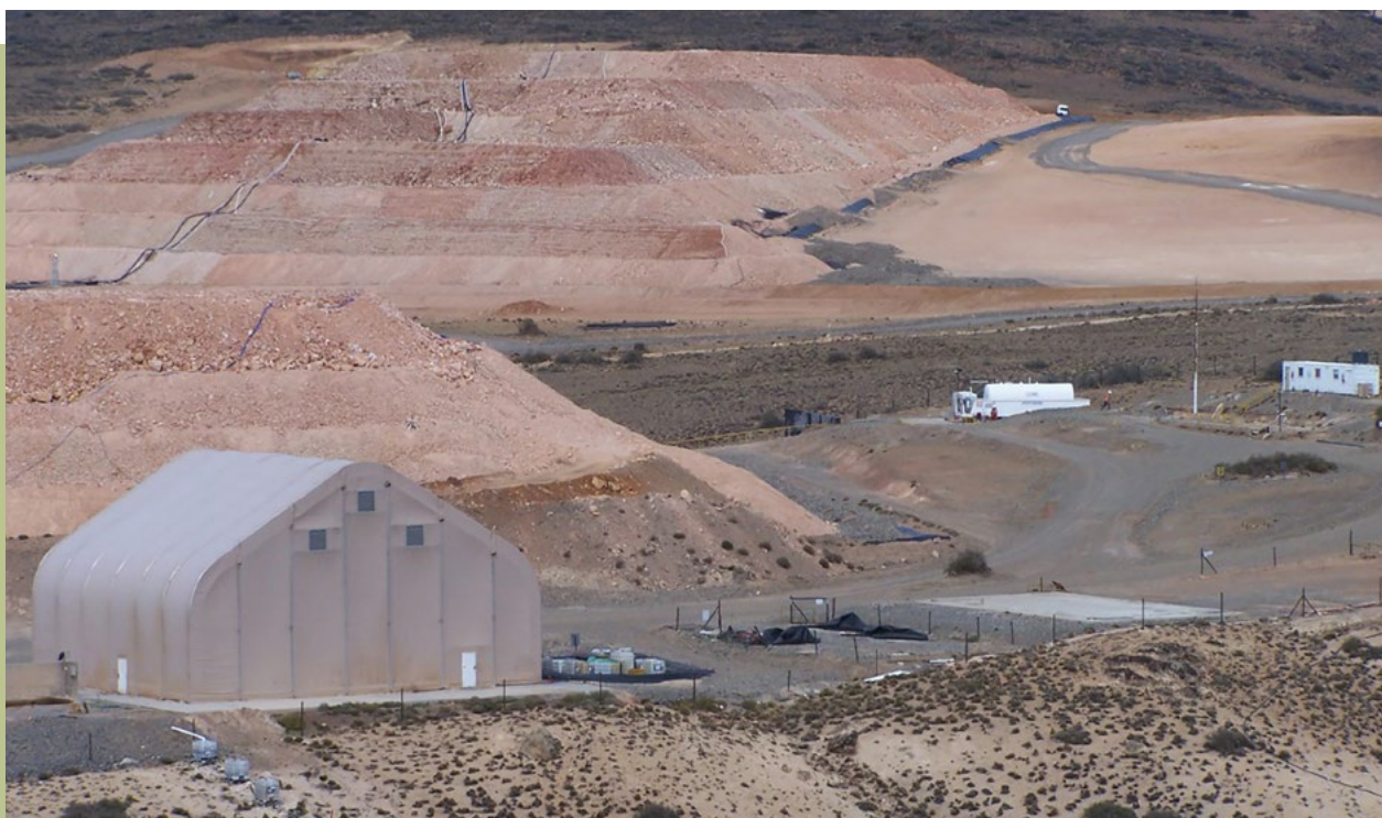
Vista de pilas. Proyecto Lomada de Leiva, Provincia de Santa Cruz, 2014.
